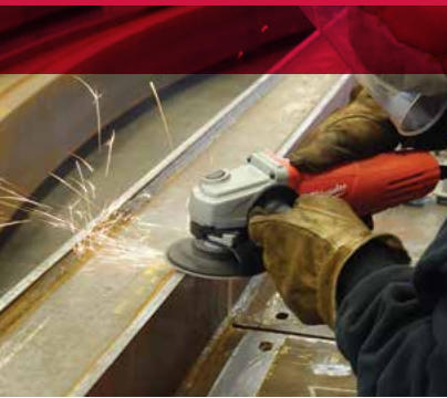
Acabado de rieles metálicos con fibrodisco.
