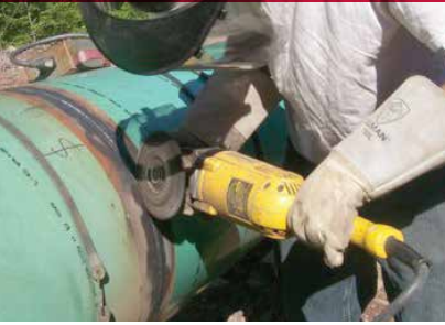
Limpieza de soldadura en unión de tubería
