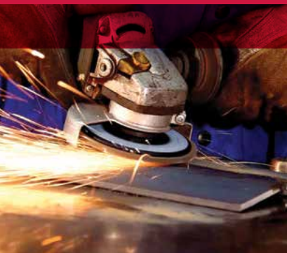
Desbastar y desvanecer una soldadura entre dos placas de acero.
